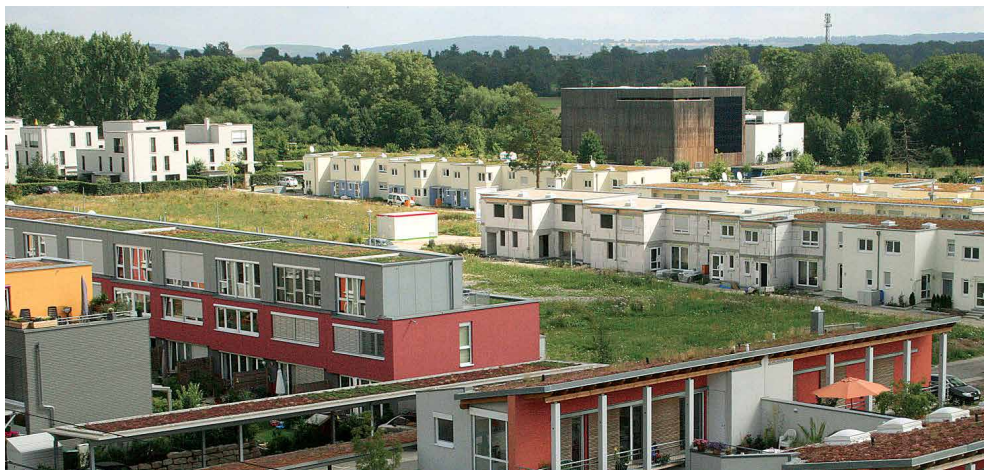
Biomasse-Heizkraftwerk (braunes Gebäude rechts im Hintergrund) im Scharnhäuser Park
